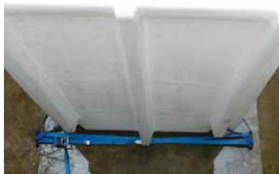
Ejemplo anclaje separador TN15
